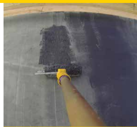
AANBRENGEN VAN DE LIJM
